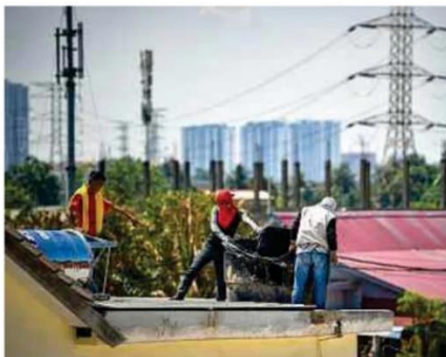
KERJA membaik pulih atap kediaman yang terkesan dengan letupan saluran gas di Putra Heights, Subang Jaya.
